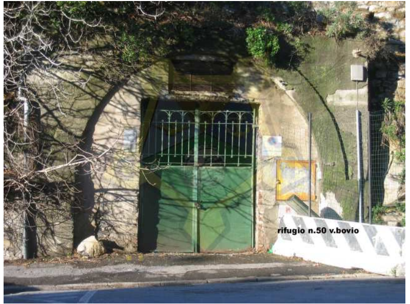
Ingresso V.Bovio galleria N.50
